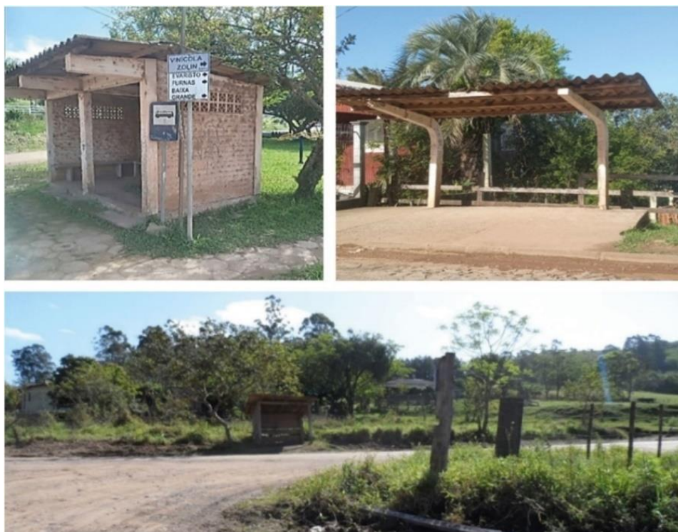
Figura 52: Exemplos de paradas de ônibus encontradas na região de Monjolo.
