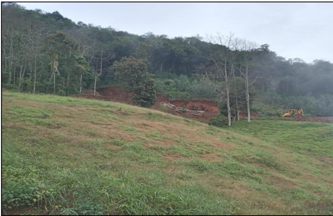
Figura 26: Vista geral da frente de lavra onde ocorre as maiores inclinações do terreno e a rocha está exposta.
